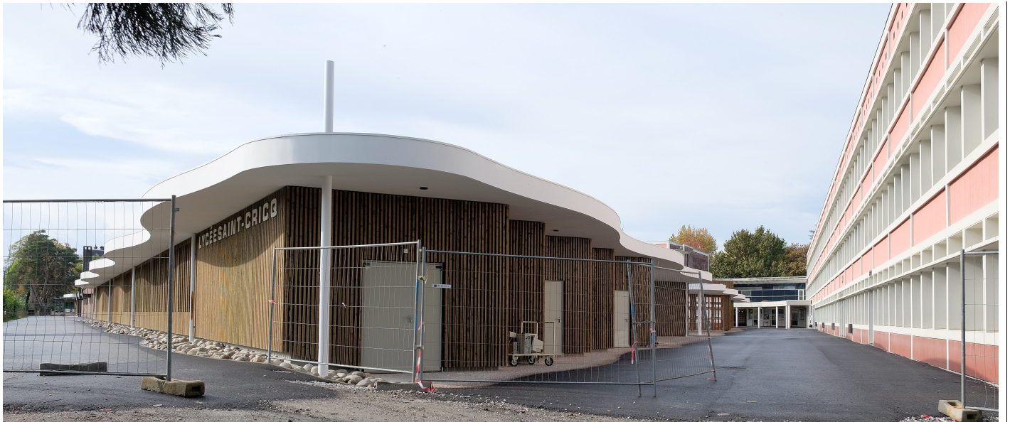
Une vue du bâtiment neuf depuis l'avenue Edouard VII
